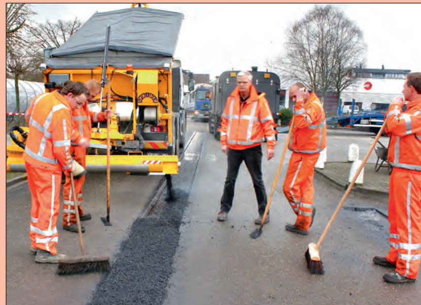
Uitgaande van wat bij reparatiewerkzaamheden normaal gebruikelijk is, was een grote ploeg van KWS naar Ommen gekomen.
