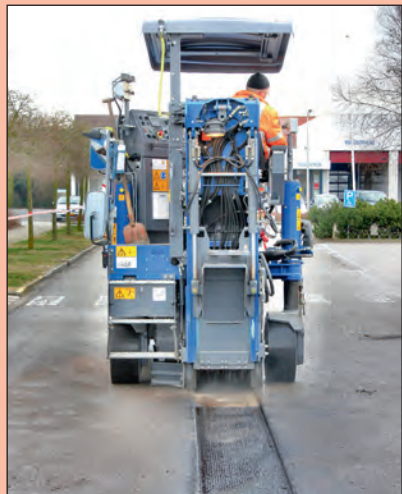
Vooraf werd met een kleine Wistra frees het slechte asfalt weggehaald.
